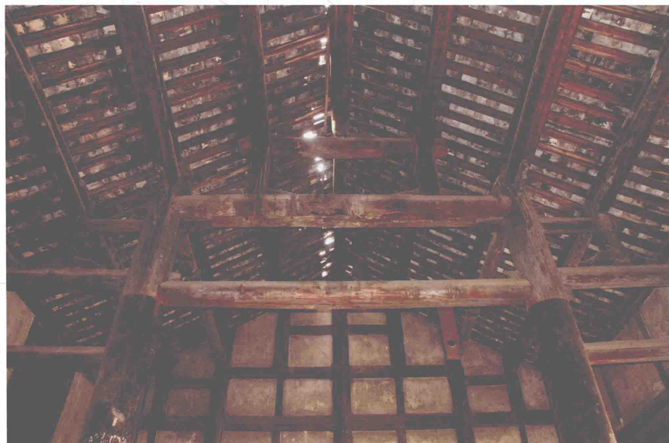
正堂梁架结构
