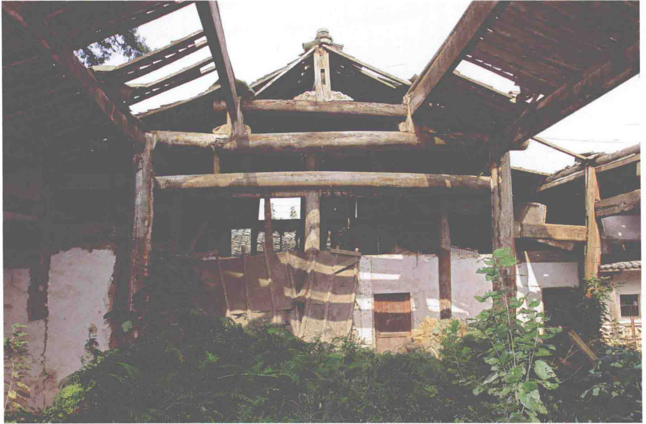
观音殿梁架结构
