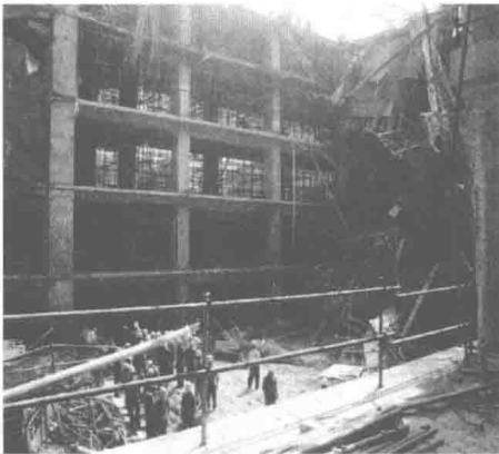
图 1.1-7 北京模架垮塌事故
