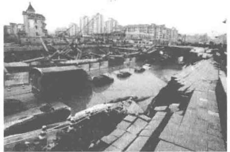
图 1.1-4 杭州地铁基坑坍塌事故
