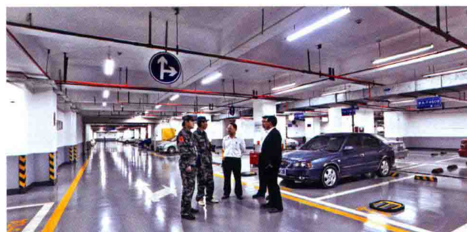
2010年，贵阳市人防执法人员对地下室管理情况进行检查
