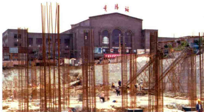
1990年，建设中的贵阳火车站人防地下城
