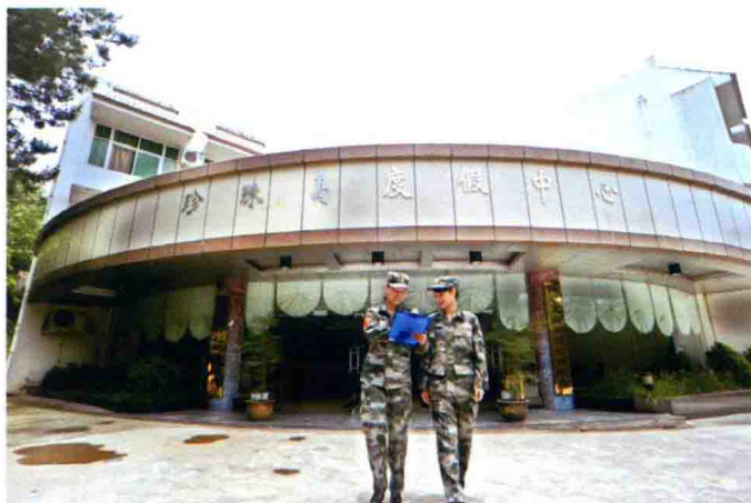
2004年建成的贵阳市人防疏散中心，同时被国家人防办确定为全国人防干部培训中心和人防职工南方疗养基地
