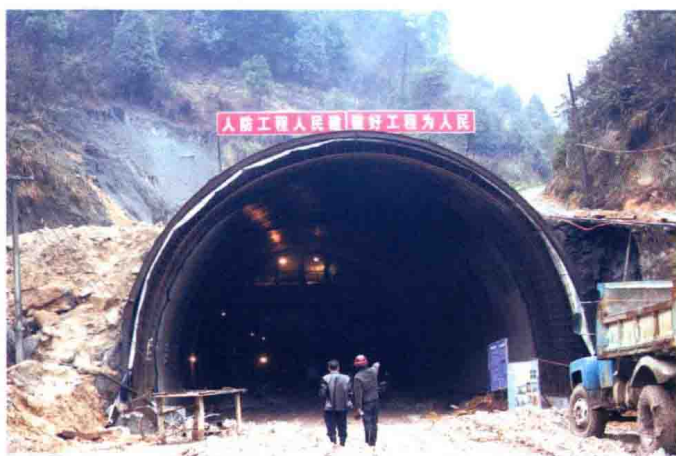
2005年，建设中的遵义官井隧道工程（兼具人防疏散干道）
