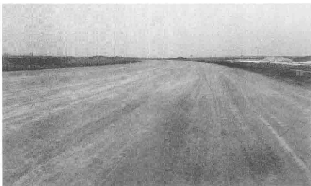
a) 掺灰土路基
