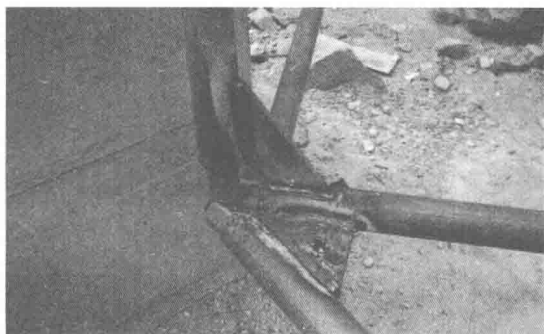
图 1-11 私自取消螺栓球节点
