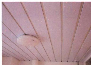
● **石膏板。**石膏板是目前应用最广泛的一类吊顶装饰材料，具有良好的装饰效果和较好的吸声性能，价格较其他屋顶装饰材料低廉，具有防火、隔声、隔热、轻质、高强、收缩率小等特点且稳定性好、不老化、防虫蛀，可用钉、锯、刨、粘等方法施工。
