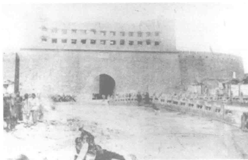
被炮火击 毁的正阳门城 楼
