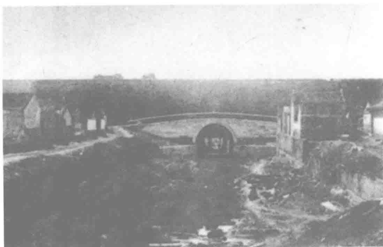
位于使馆界 南面的水门（亦 称为水关）
