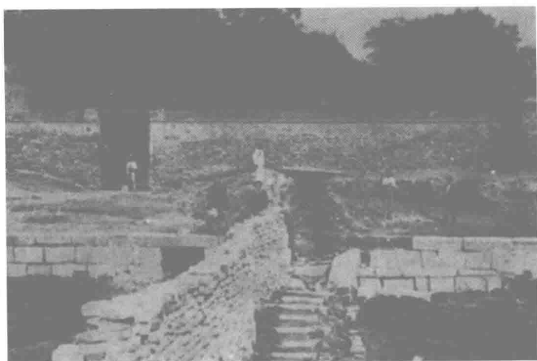
连接英、日 使馆的防御工事 和坑道
