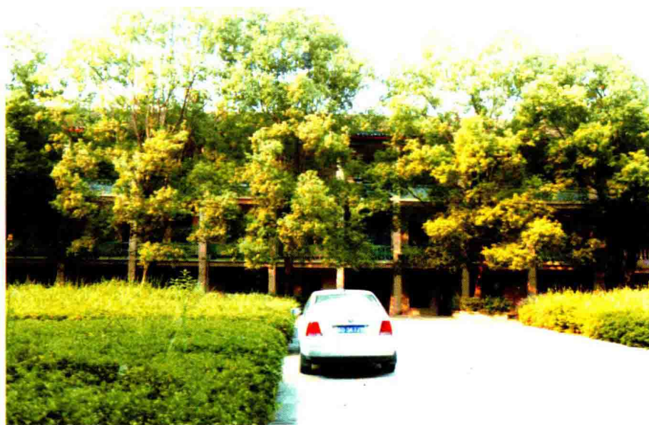
原下马渡镇区公所办公楼。
