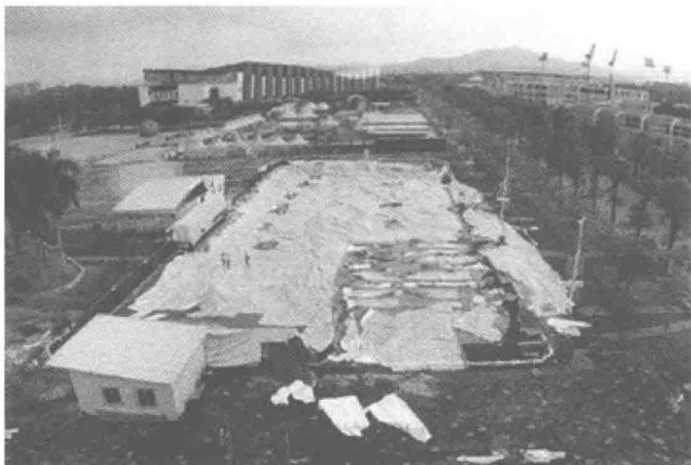
图 1-7 广州奥体羽毛球综合馆暴雨坍塌
