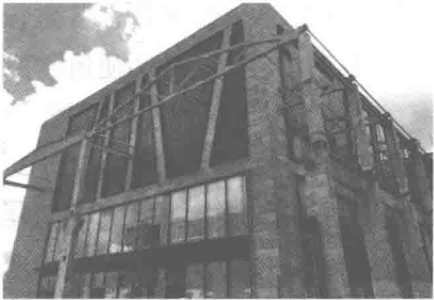
图 1.3 排架结构
