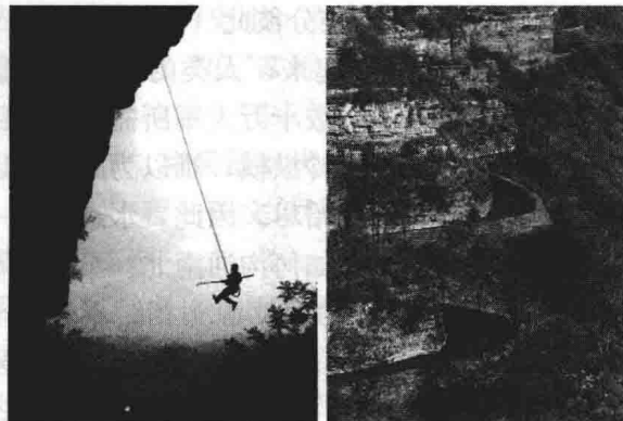
悬吊在悬崖上施工的民工
