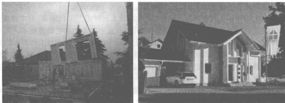
图 1-1 德国装配式住宅施工现场
