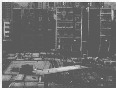
图 1-11 新加坡装配式建筑施工图
