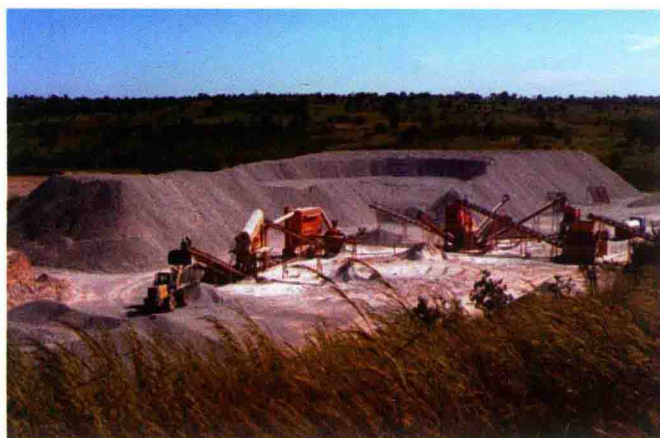
道砟厂施工掠影 Construção da fábrica de balastro
