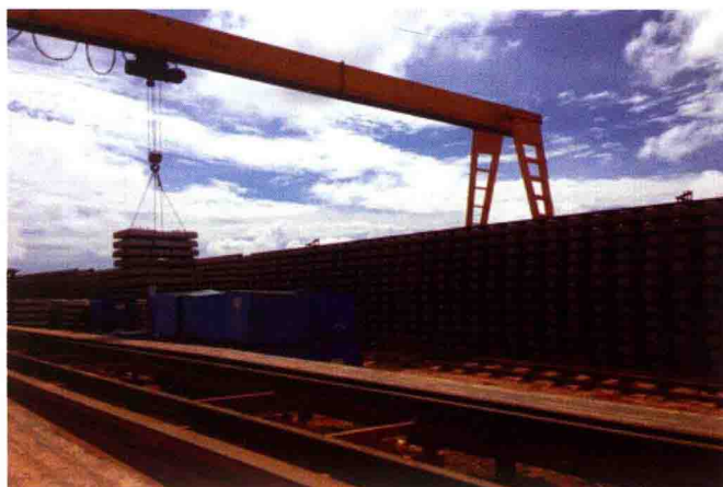
轨排厂施工掠影 Construção da fábrica de carril
