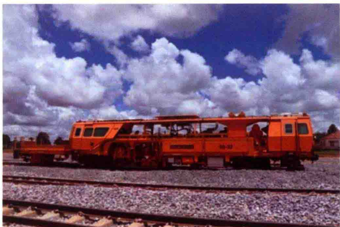
大养机施工 Execução de trabalhos com acatadeita
