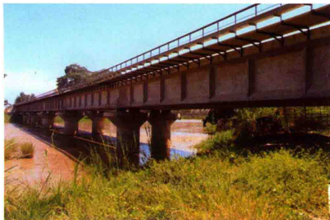
桥梁施工掠影 Construção de ponte
