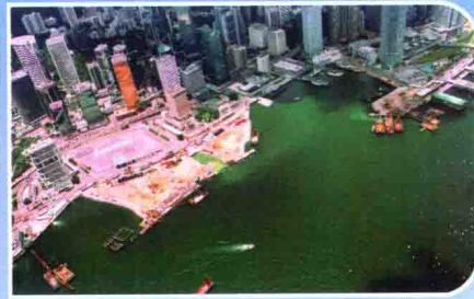
■ 香港中环填海第三期工程
