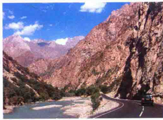
■ 塔乌公路修复改造项目
