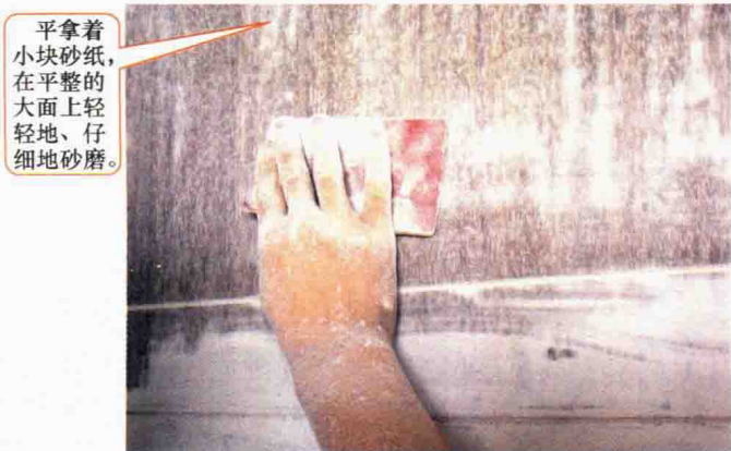
图 5-14 大面积处腻子砂磨
