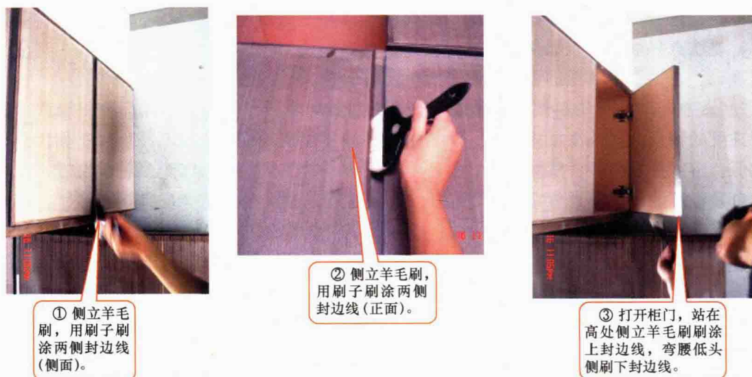
图 5-17 木胶合板柜面刷涂第一遍 PU 封闭底漆（先刷细部再刷大面）
