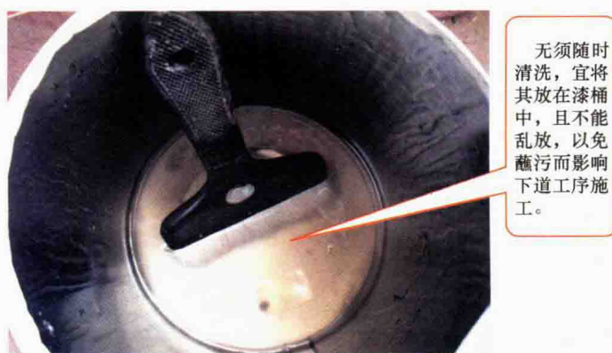
图 5-18 施工过程中羊毛刷的存放
