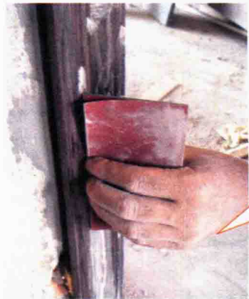
图 5-13 门套线等小面积处腻子砂磨
