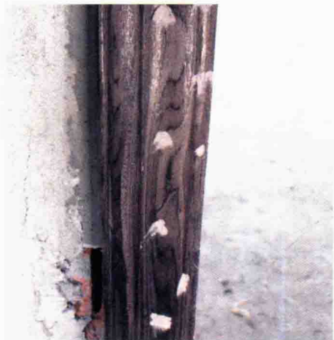
图 5-11 门套线等小面积处腻子干燥后的表面效果
