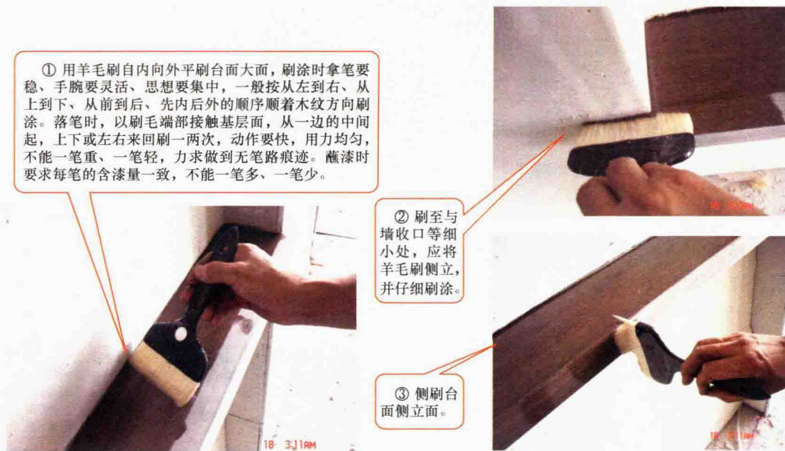
图 5-16 木胶合板台面刷涂第一遍 PU 封闭底漆
