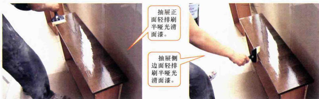
图 5-20 木胶合板面刷涂面漆
