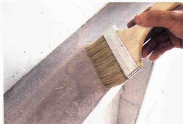
图 5-15 砂磨腻子后清扫
