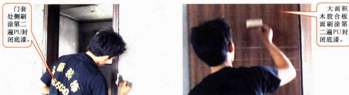
图 5-19 门套线、木胶合板面等处刷涂第二遍 PU 封闭底漆
