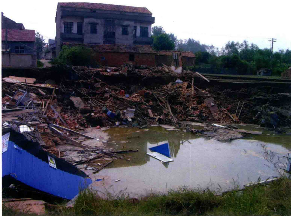
图片六 2014年9月5日,武汉市江夏区法泗街岩溶地面塌陷进程对比。该照片显示:照片五中左侧植物显露,右侧破损房屋已消失,塌陷坑中已经积水,显示塌陷正在进一步发展(樊永生 提供)
