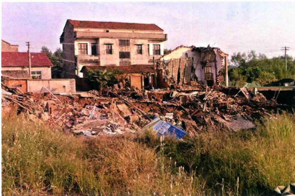
图片五 2014年9月5日,武汉市江夏区法泗街岩溶地面塌陷进程对比。该照片显示:塌陷坑周围居民房屋受损,右边房屋已垮塌(陈艳梅 提供)
