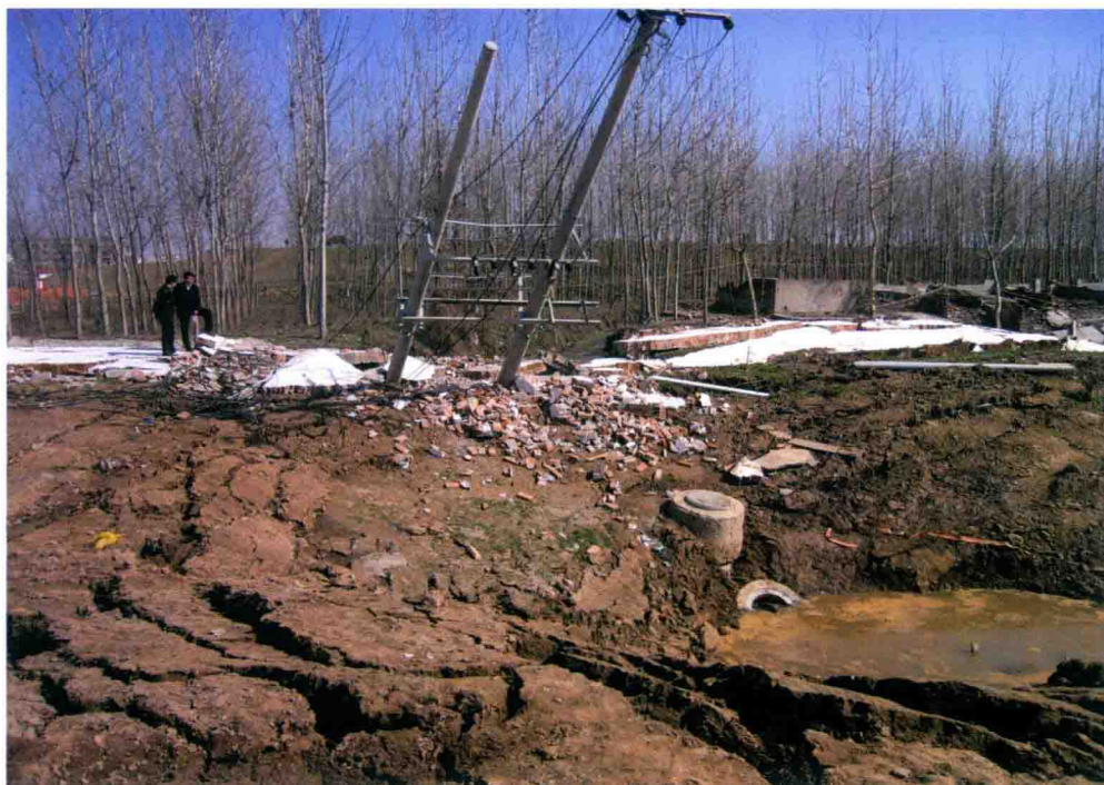
图片一 2008年2月29日,武汉市汉南区陡埠村岩溶地面塌陷:塌陷坑附近的电杆歪斜、变压器垮落、排水系统被破坏(罗小杰 摄)
