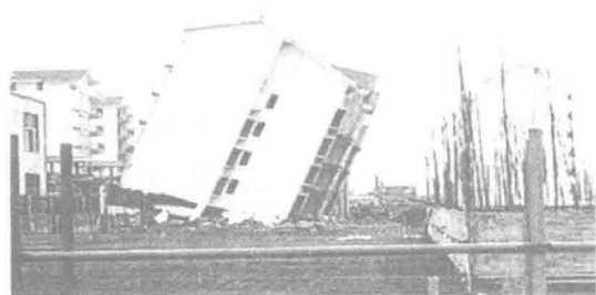
图 1-2 河北省黄骅市枫景华城小区危楼
