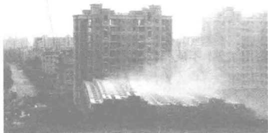
图 1-1 上海景苑小区住宅楼整体倒塌
