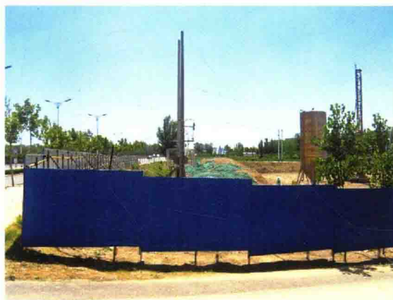
图 2-5 新建 110kV 学院变电站站址
