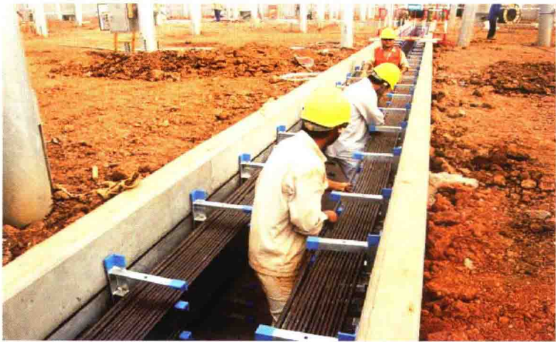
图 1-11 多线路同时施工图
