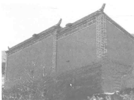
图 1-4 土、砖混用承重墙体
