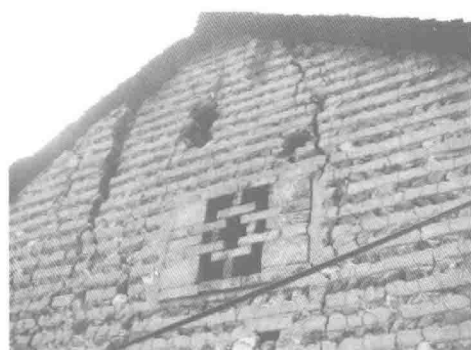
图 1-5 土、石混用承重墙体
