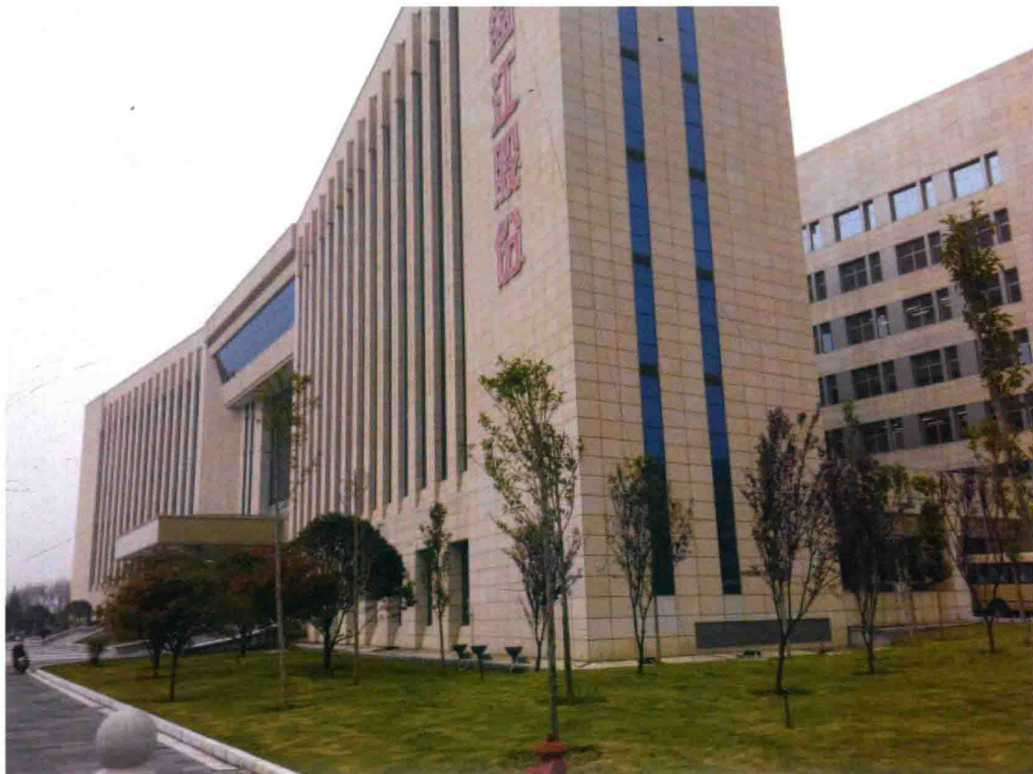
盘江精煤股份公司办公楼（2013 年摄）
