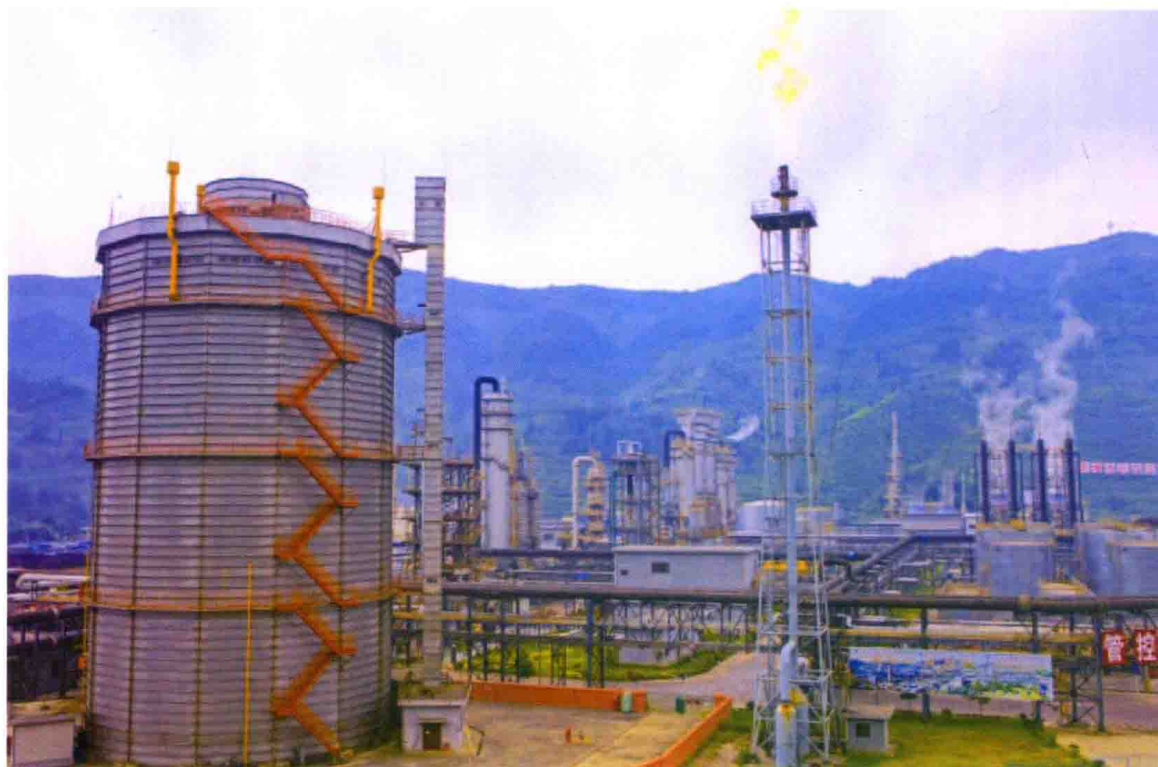
420 万吨 / 年 选煤、200 万 吨 / 年焦炭黔 桂煤电化一角 (2015 年摄)
