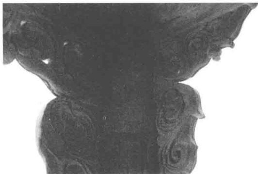
图 1-7 被简单草率修复的木构件(山西长治观音堂)
