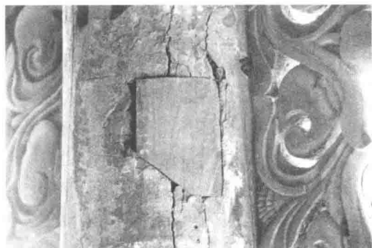
图 1-7 被简单草率修复的木构件(山西长治观音堂)
