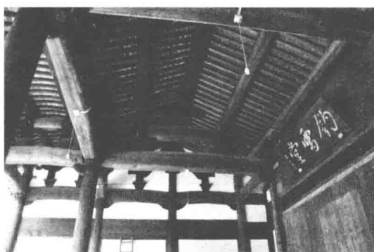
图 1-3 利用新旧构件组合修复后的古建筑 （安徽黄山钓雪堂）
