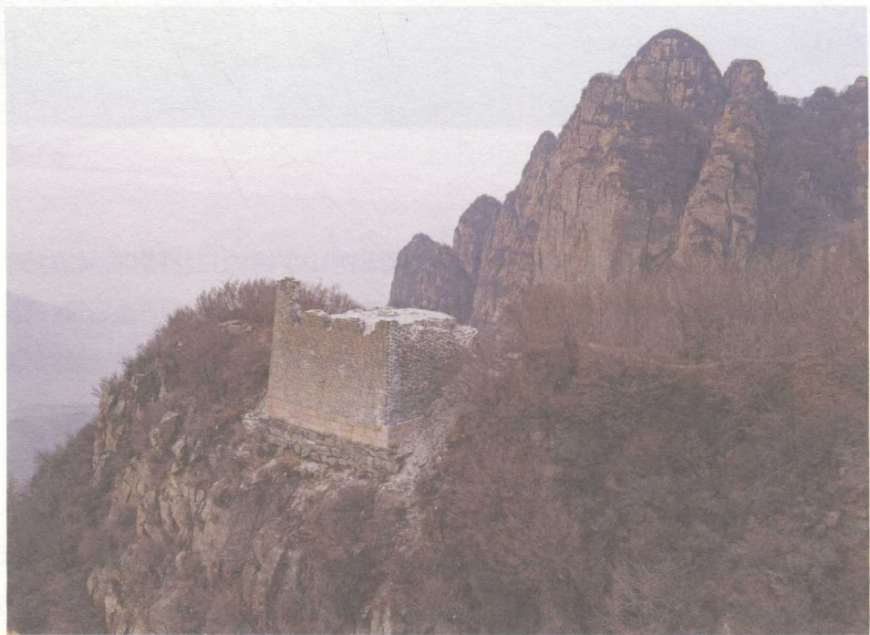
南水峪关东北、玻璃台村北山上敌楼
