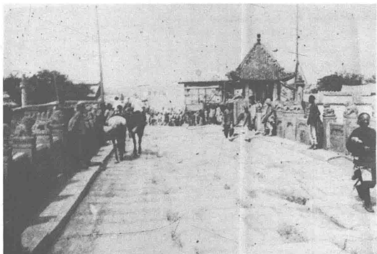
马可·波罗桥（卢沟桥——译注），北京近郊
