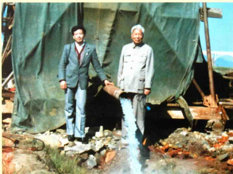
1993年，和校友庞忠和(左)在海南石梅湾热水钻孔施工现场
