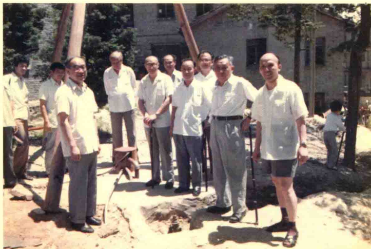
1989年，在江西庐山水井施工现场 (前排左起：王德滋、肖楠森、张祖还、俞剑华、徐克勤、罗国煜；后排右一为胡受奚)
