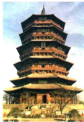
图 1-4 山西应县木塔
