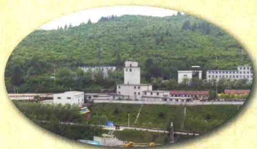
▲在通钢板石铁矿，马万水分公司实施精细化管理，受到业主高度赞誉
