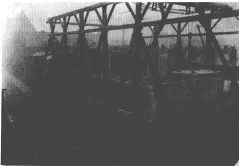
图 2-2 1903 年 John Alexander Brodie 在利物浦埃尔登街建筑作品 (采用预制混凝土作为建筑材料)
