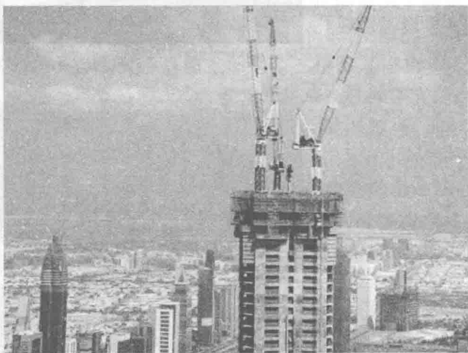
图 1-7 哈利法塔用超级起重机
