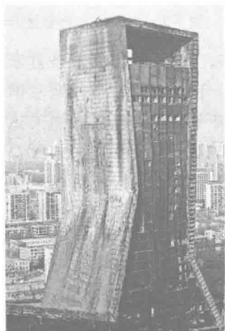
图 1-8 央视文化中心大楼火灾后
