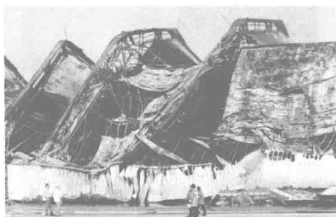
图 1-7 布鲁塞尔国际机场火灾后坍塌
