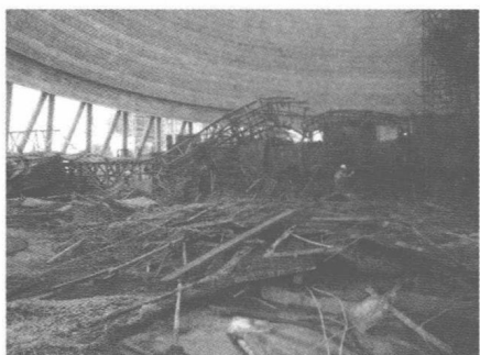
图 1.1-3 江西丰城电厂滑模垮塌事故
