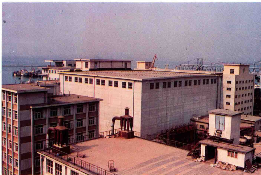
◁1982 年 1 月建成的 5000 吨级 2 号冷库
