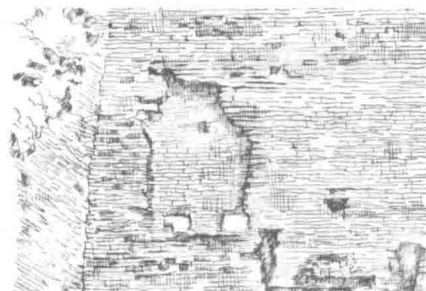
5 修缮类: 意大利罗马勒良城墙修复(运用“底框”法, 新修复的城墙略微后退做底, 原有城墙为框)
