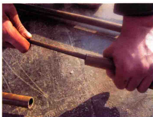
图 5.2-1 管口采用圆锉刮铣光滑、无毛刺
