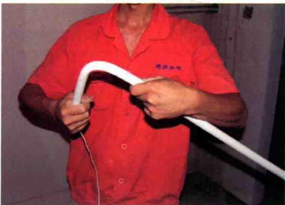
图 5.3-3 使用弯管弹簧弯曲管路
