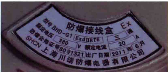
图 2.6-3 防爆接线盒铭牌（铭牌上标有防爆合格证号）
