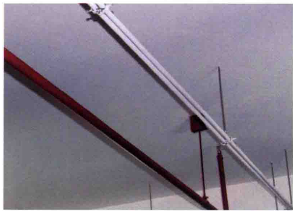
图 4.3-1 电气钢管与其他专业管道平行敷设，安全距离符合要求
