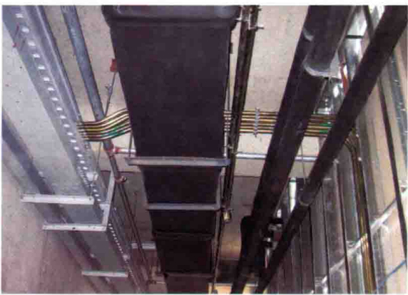
图 4.3-2 电气管路 with 风管、设备管道交叉敷设，位置合理，保证安全距离求
