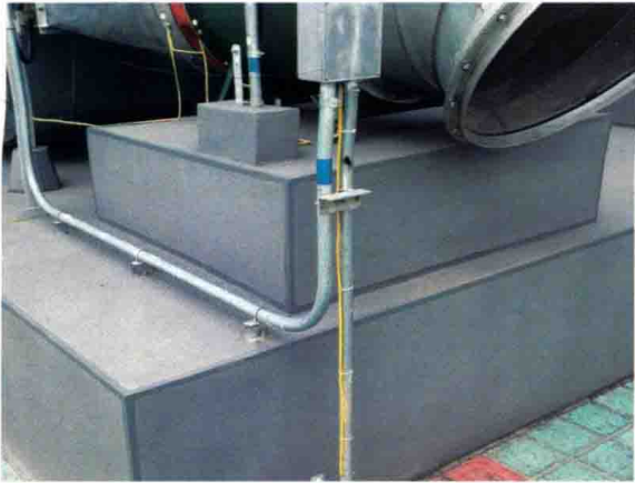
图 2.1-1 屋面等潮湿场所采用镀锌焊接钢管敷设
