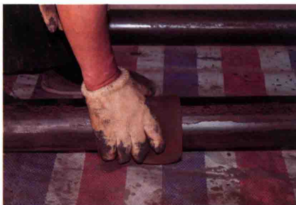
图 5.1 使用砂纸对钢管外壁除锈
