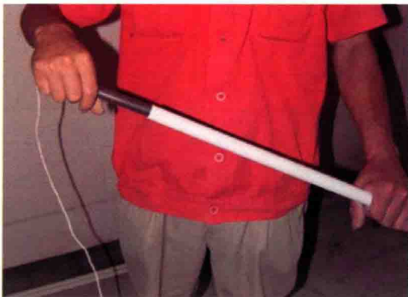
图 5.3-3 使用弯管弹簧弯曲管路
