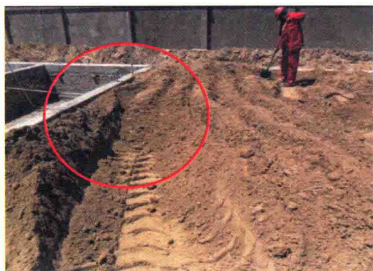
图 1-1 回填土单层厚度过大
