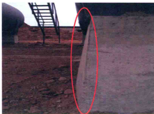
图 1-8 设备基础几何尺寸偏差过大
