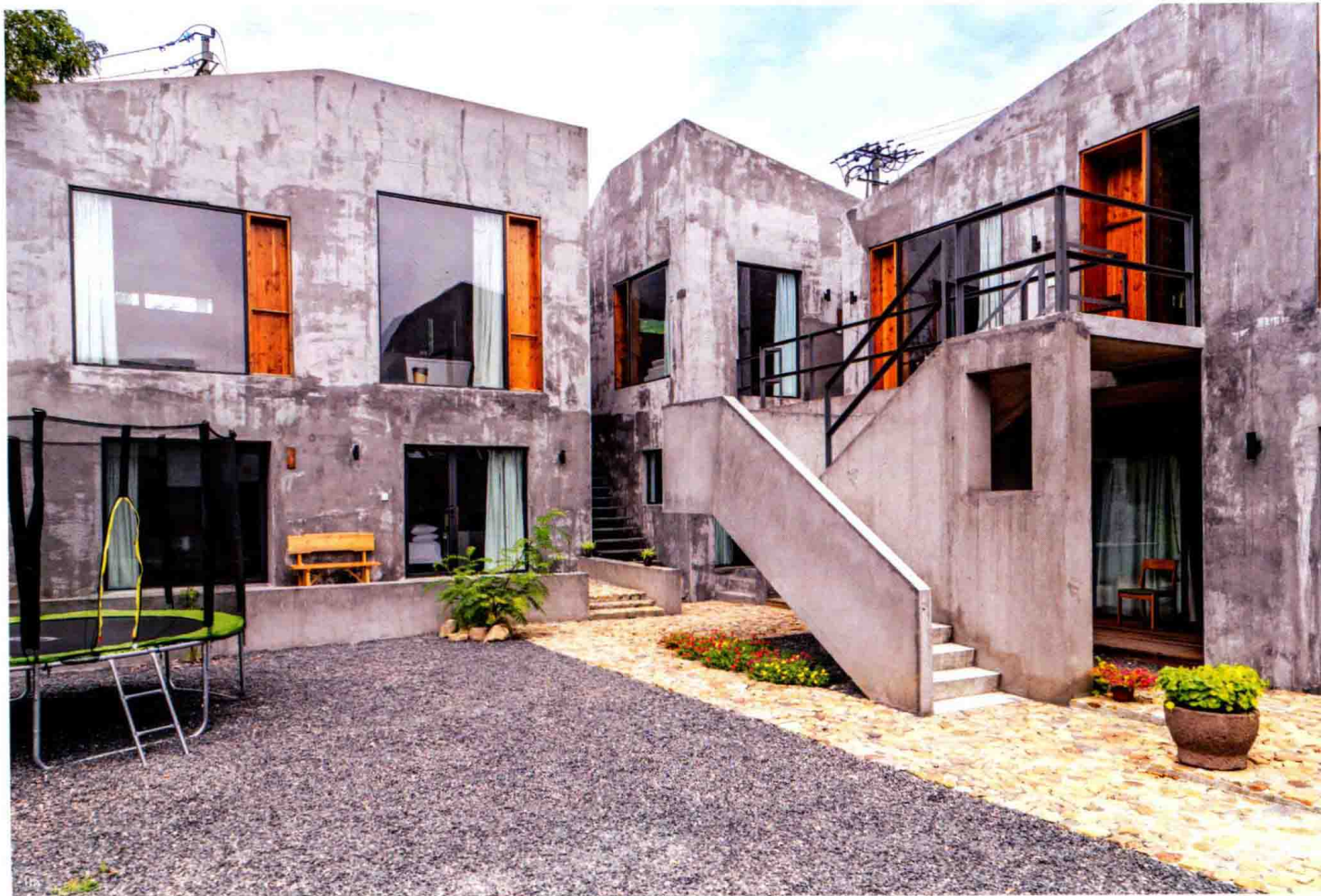
05/ 清水混凝土墙面
