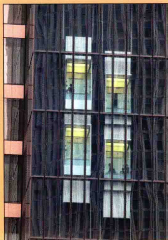
日本名古屋的双轿厢电梯
