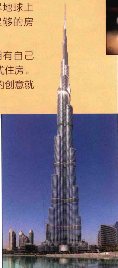
迪拜哈利法塔高829.8米，是目前世界第一高楼。
