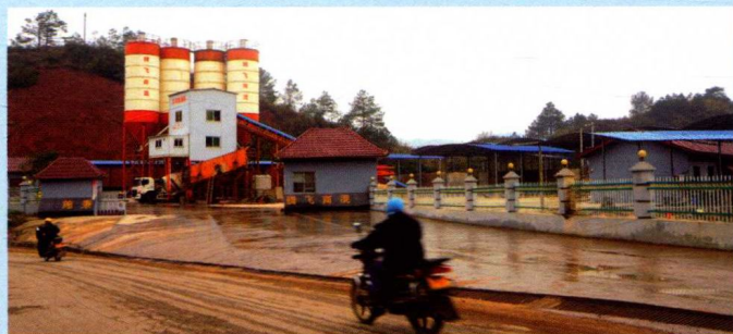
县腾飞商品混凝土有限公司厂区
