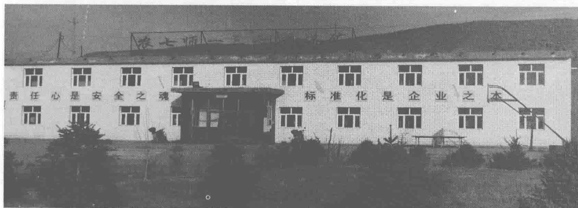
图 1 和布克赛尔县和什托洛盖 137 团煤矿矿部
