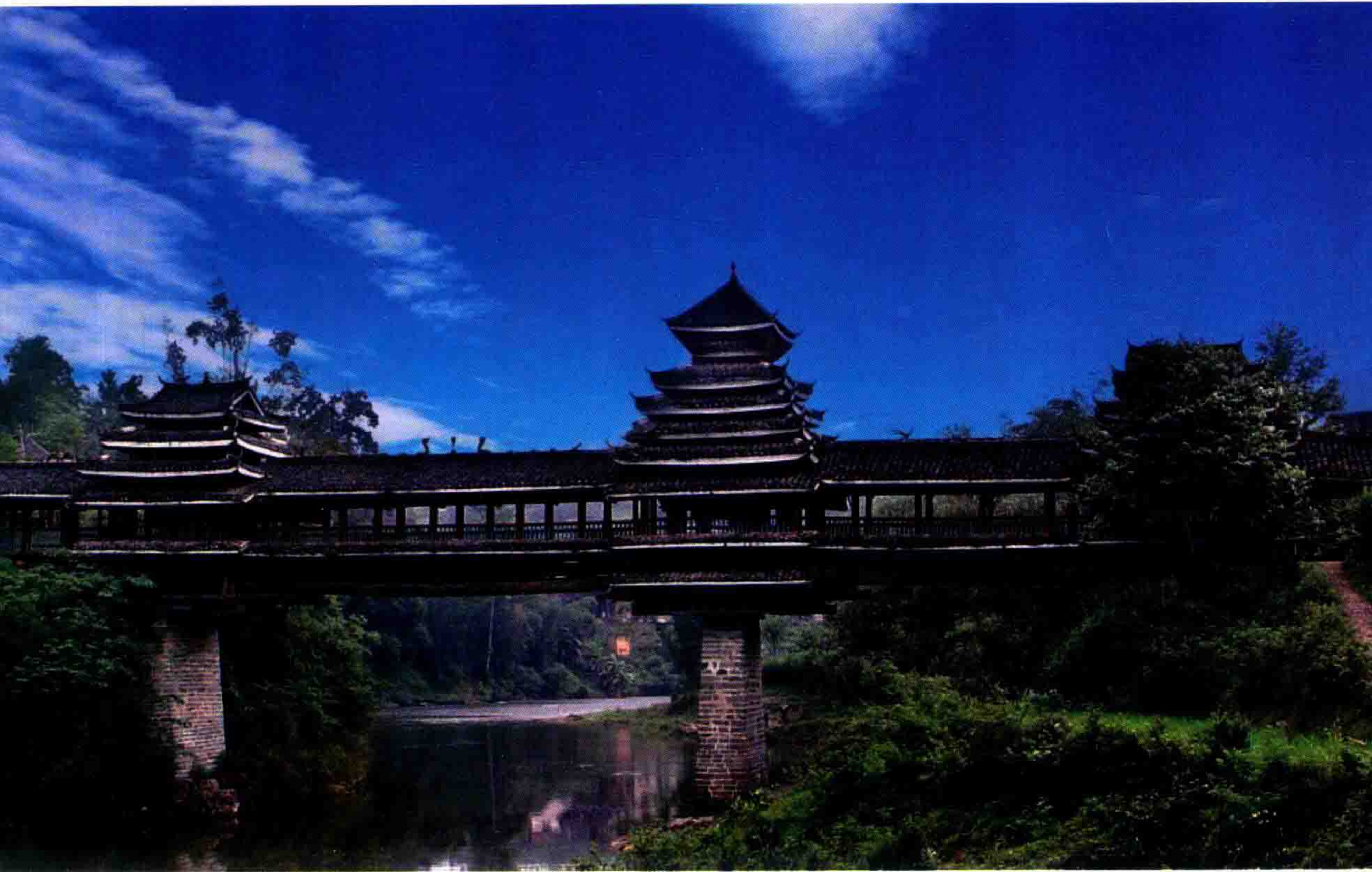
地坪风雨桥（杨再元拍摄）
