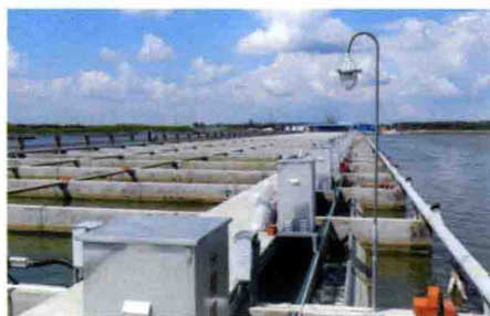
砖混结构养殖水槽
