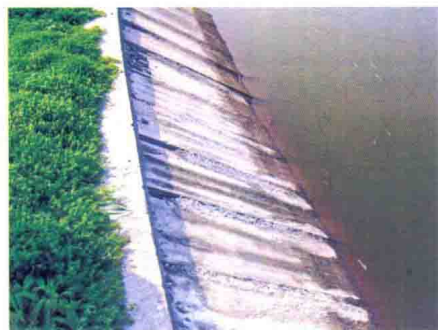
水泥预制板护坡
