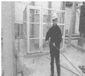
图 1-17 电缆沟穿线穿管
