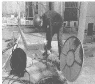
图 1-19 排水管打孔
