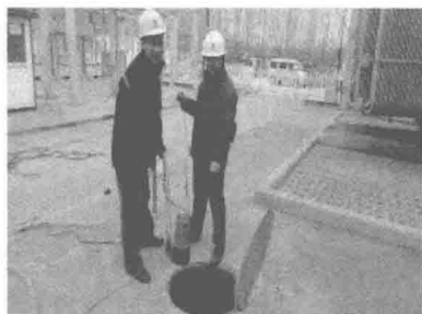
图 1-20 水泵放入油池
