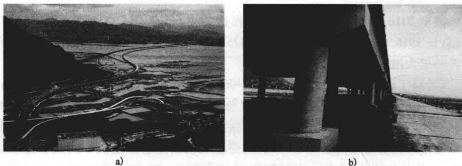
图 1-1 宁德滨海特大桥概貌
