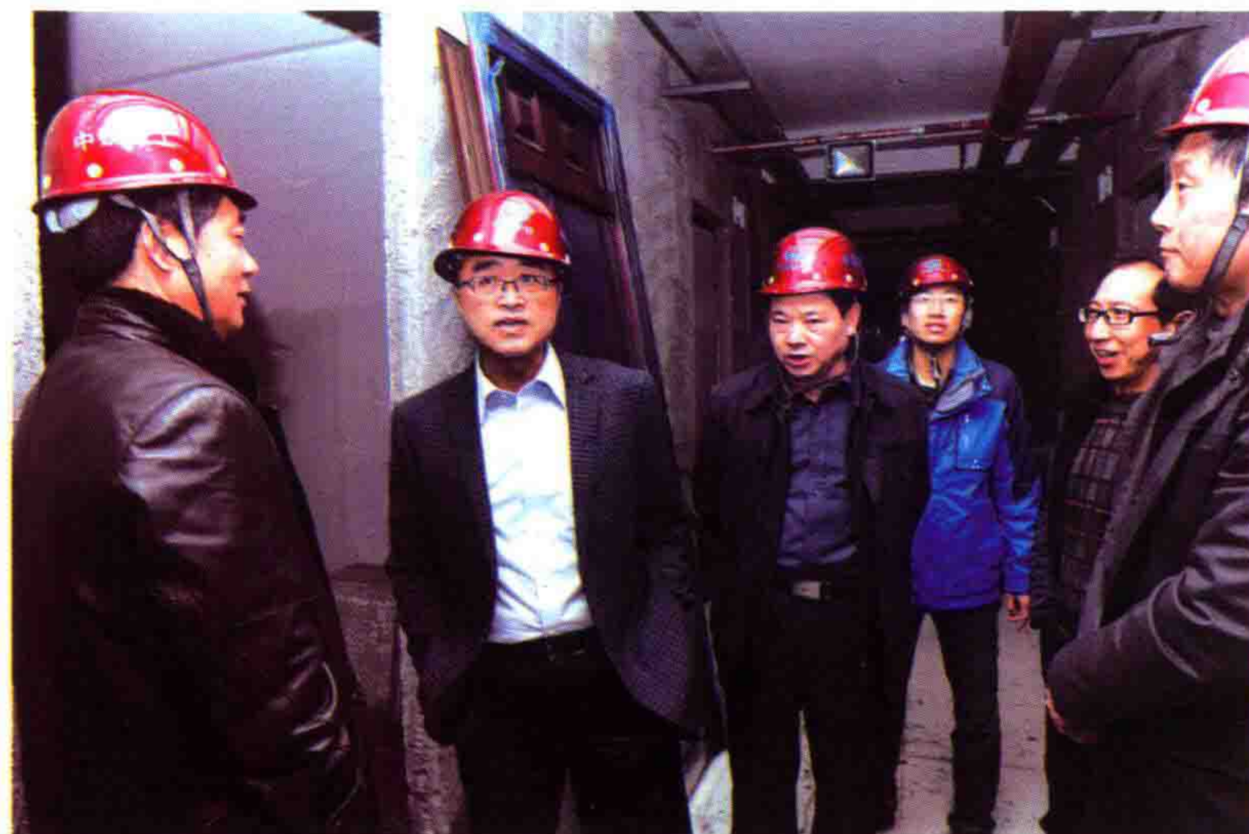
◀ 2015年3月11日，贵州省副省长陈鸣明来校视察二期扩建工程进度情况。
