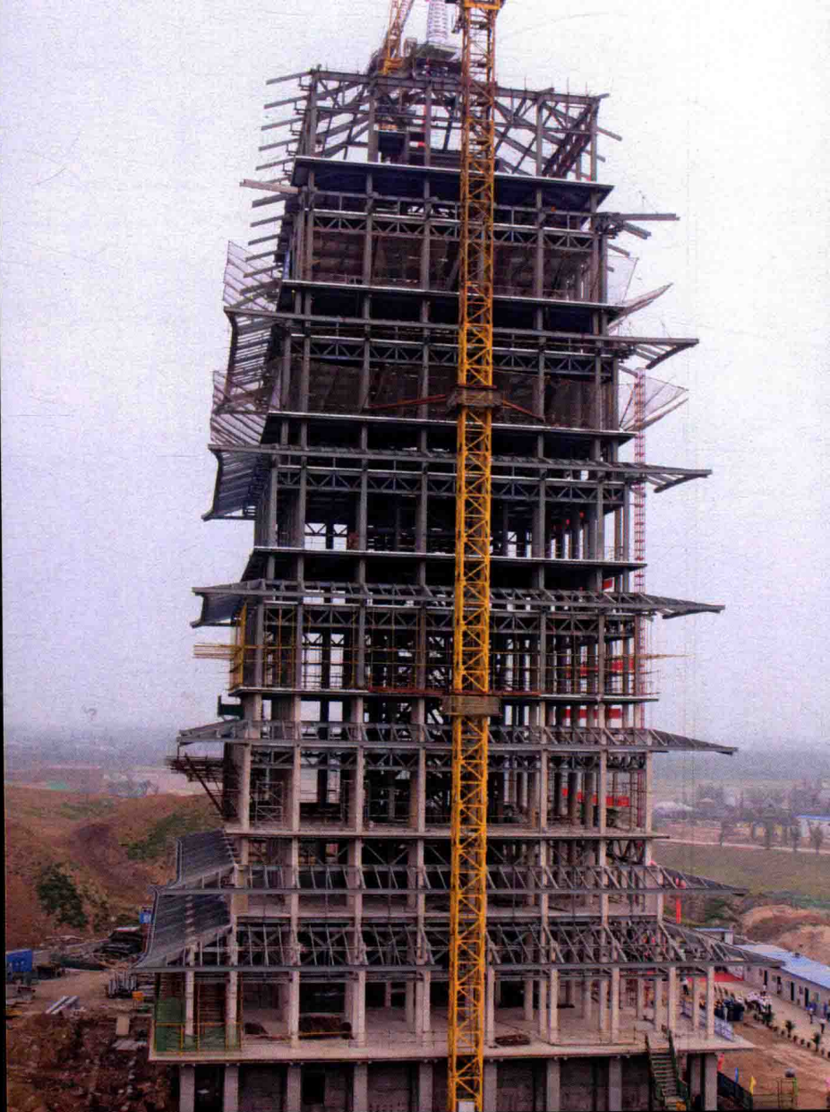
长安塔施工(一) CHANGANTA SHIGONG
