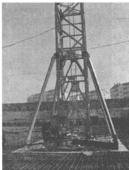
图 1.2-4 十字梁底架结构
