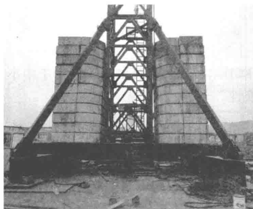
图 1.2-5 压重式底架
