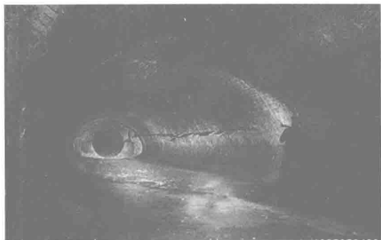
图 1-5 伦敦 150 年前建的排水管渠
