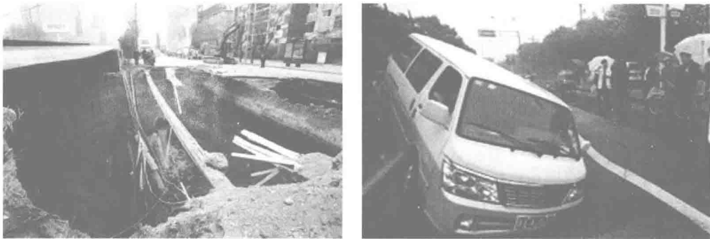
图 1-8 北京、杭州路面塌陷事故
