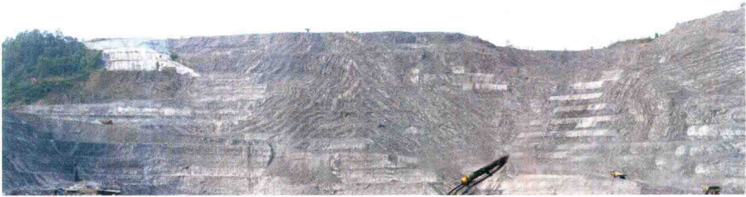
澳大利亚澳华黄金有限公司（露天开采现场）
