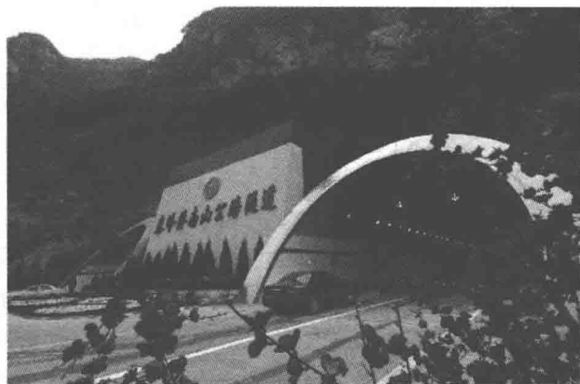
图1-4 秦岭终南山公路隧道
