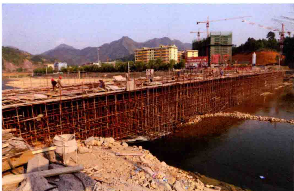
建设中的县城都柳江大桥（2013年摄）
