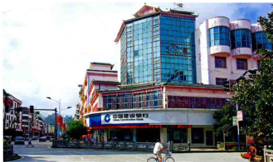
县建行大楼（2012年摄）
