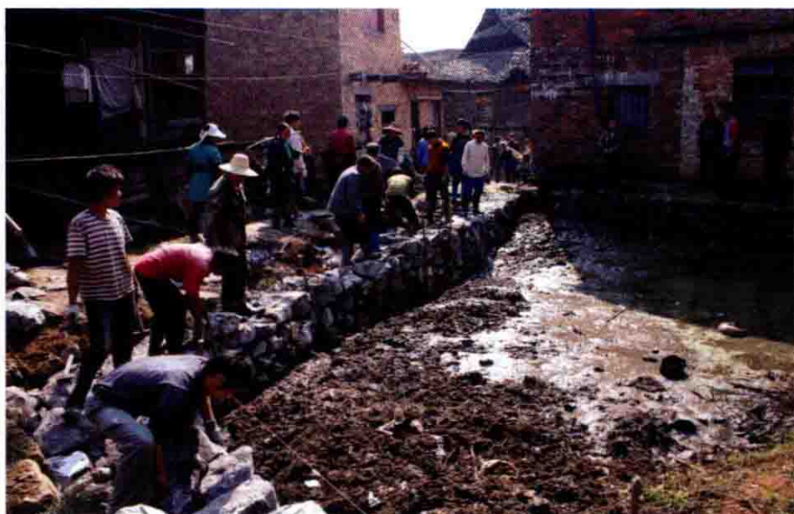
村寨道路建设（2012年摄）
