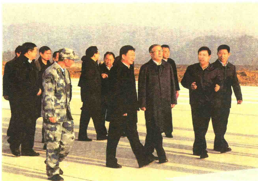
2015年12月2日,湖北省委书记、省人大常委会主任李鸿忠(右三)一行赴十堰武当山机场建设工地调研,了解项目进展情况,看望慰问工程建设者
